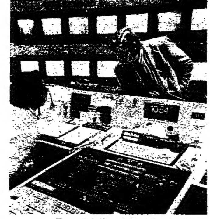
مركز مراقبة حركة السفن داخل النفق
